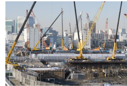
建築工事現場
